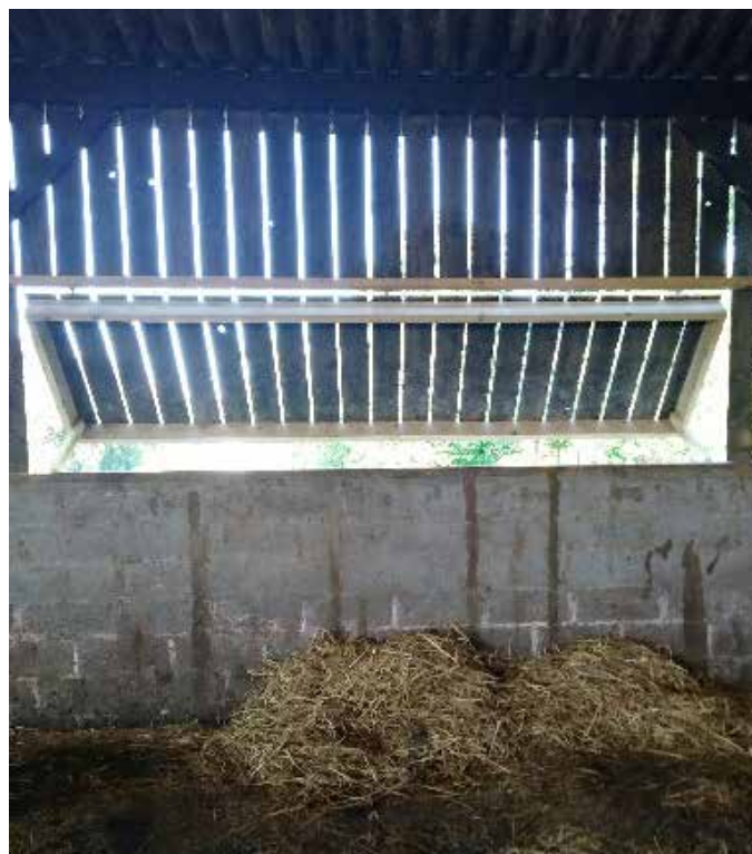
Photo 9 trappe vue intérieure (Crédit photo : Idele)
