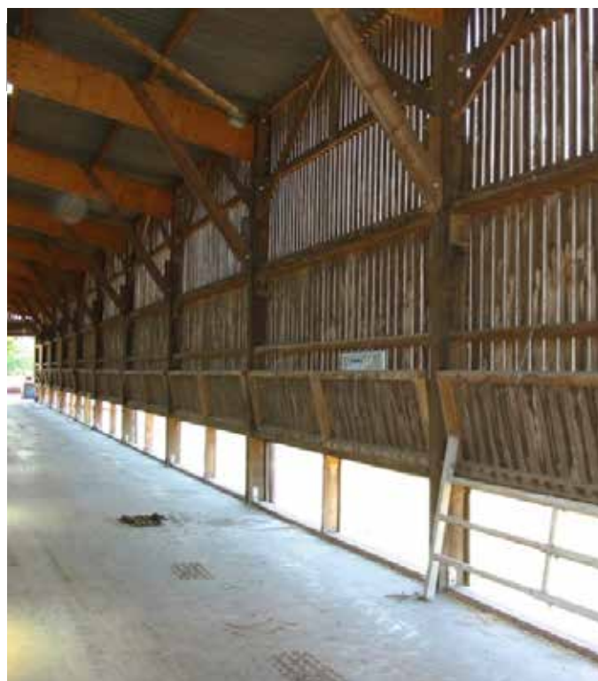
Photo 10 volets en partie basse (Crédit photo : Idele)
