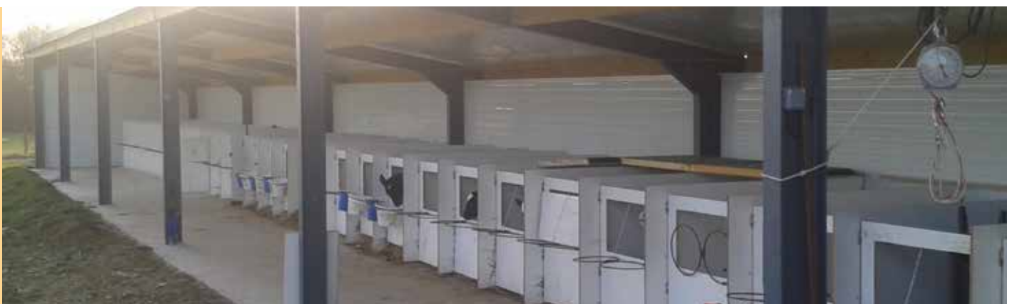
Photo 14 : Des veaux protégés de l'impact du rayonnement solaire par une toiture et un mur isolés
