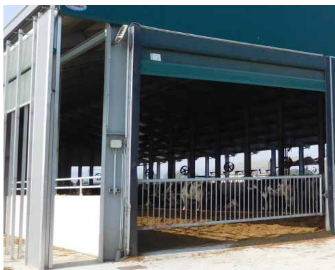
Photo 6. Brise-vent déporté (Crédit : photo BTPL)
