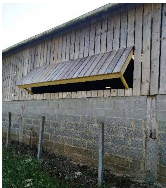
Photo 8 trappe protégeant du rayonnement (Crédit photo : Idele)
