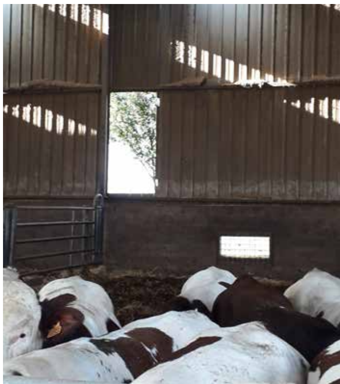
Photo 7 démontage de bardage à privilégier au nord et à l'est (Crédit photo : Idele)
