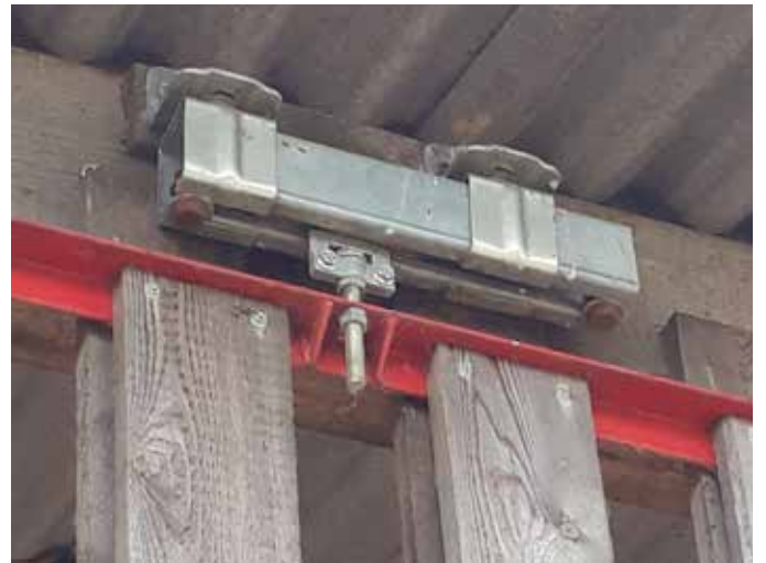
Photo 15 bardage bois modulable (Crédit photo : Idele)
