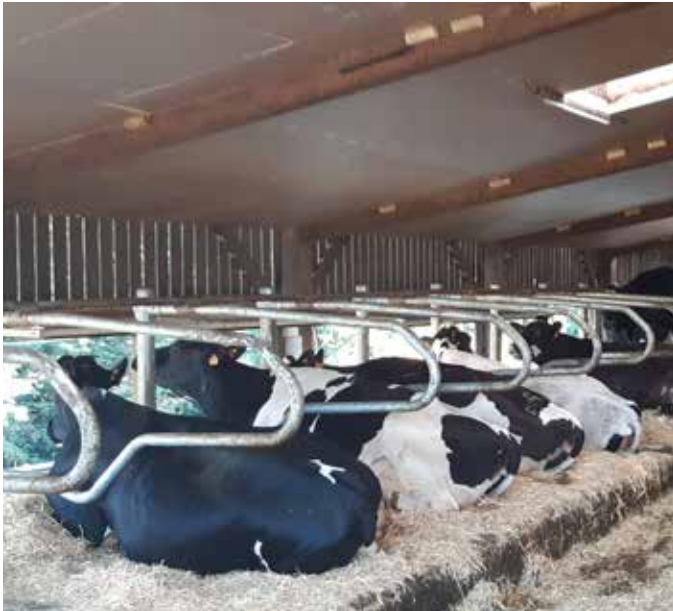
Photo 11 volets en partie basse, isolation d'une toiture basse et peinture d'ombrage type serre appliquée en dessous des translucides (Crédit photo : Rhône Conseil Elevage)
